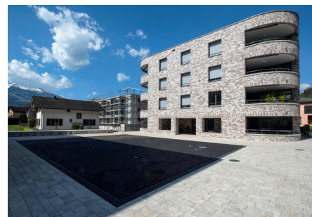
Der Siedlungsplatz zwischen den Häusern wird noch begrünt und möbliert.
